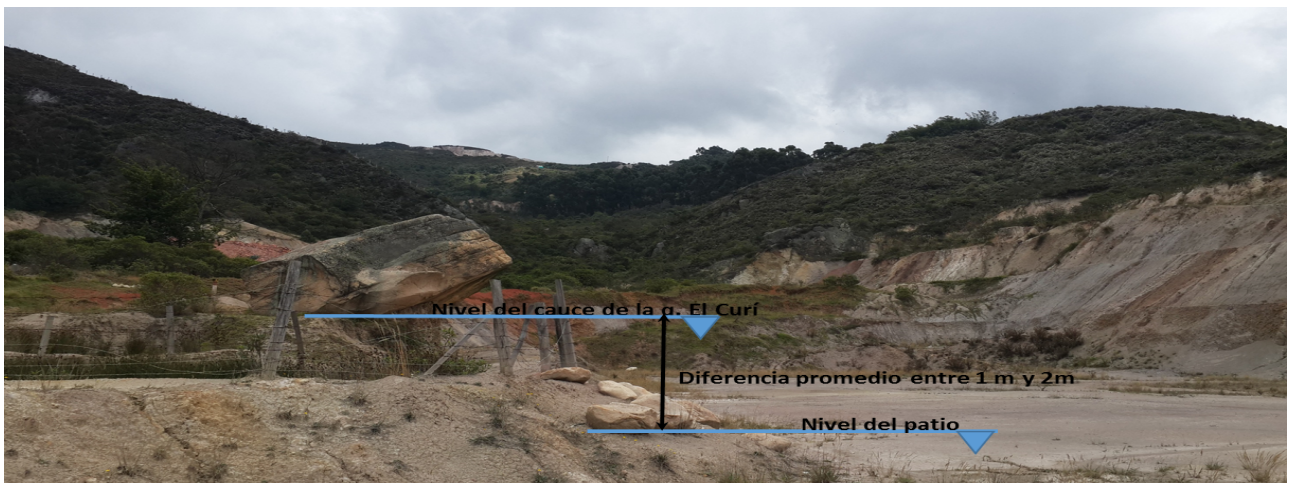
Fotografía 2 – Evidencia del efecto (cauce colgado) de la antigua extracción de arcilla en el cauce de la quebrada El Curí
